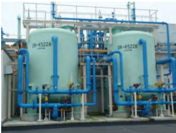
一次処理設備 直径3,000mm 胴長3,500mm
